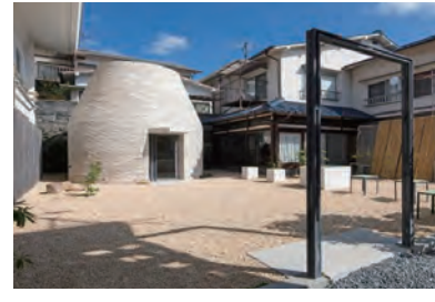
一華寺 無尽塔新築工事(呉市西中央)
